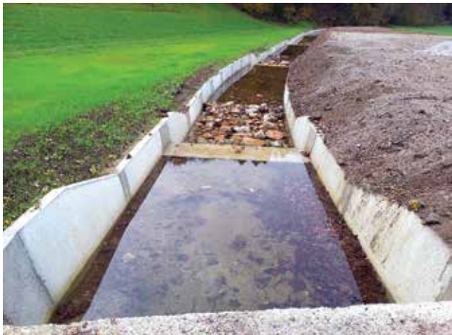
Slika 1: Reka Jablanica. Reka, ki je danes »odtočni kanal«. Ureditve, kakršnih si ne želimo. (Foto: Arhiv ZZRS.)
