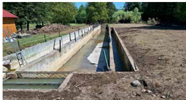
Ribogojnica Ljubno po prvih korakih sanacije zahvaljujoč marljivim rokam peščice pripadnih članov.
