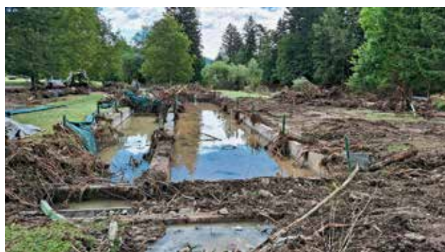
Zmleta infrastruktura ribogojnice Ljubno
