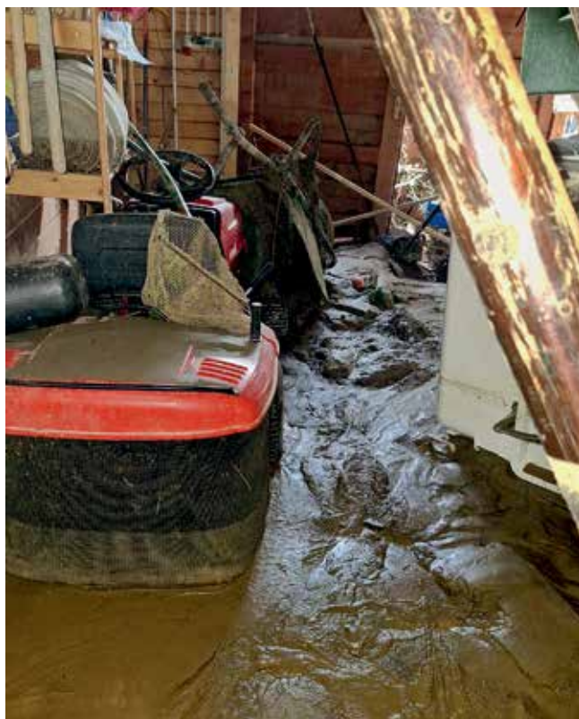
Mulj v notranjosti objekta
