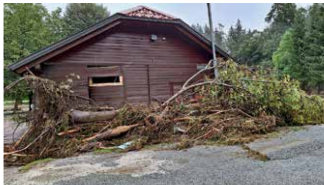
Ribogojni objekt na Ljubnem po ujmi.
