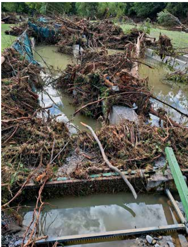
Zmleta infrastruktura ribogojnice Ljubno
