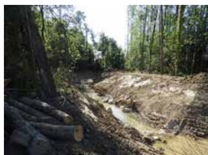
Izkop Novo izkopen rokav v Dolenjah (2021) ni rokav, je kanal.
