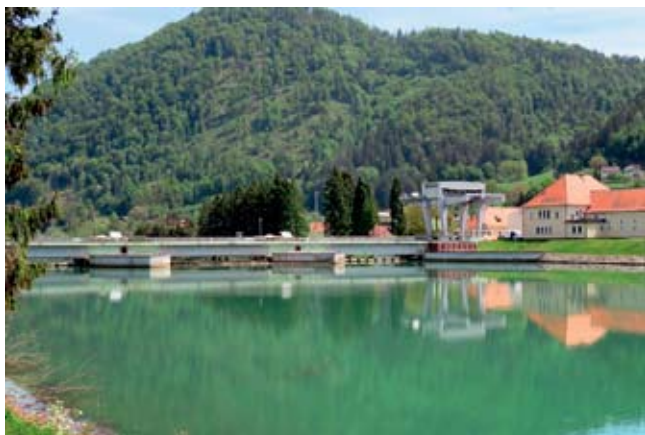
Jezero na jezovni zgradbi v Dravogradu.
