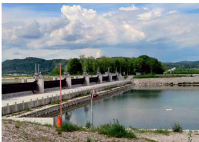
Prelivni objekt visokih voda Save z hidromehansko opremo.
