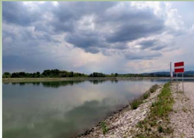
Detalj erozijske zaščite vodne brežine z lomljencem, ki pa bo naravi in ljudem prijaznejša po razrasti trav ter makrofytov.
