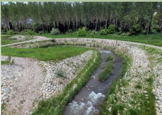
Detalj ureditve nove ribje selitvene poti in nadomestnega habitata reofilnih vrst rib.
