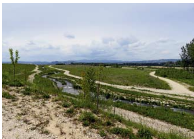
Odlično speljana in hidrotehnično izvedena ribja selitvena pot ter nadomestni habitat za reofilne vrste rib, jo bo pa potrebno še zasaditi z drevjem za boljše osenčenost umetne struge.
