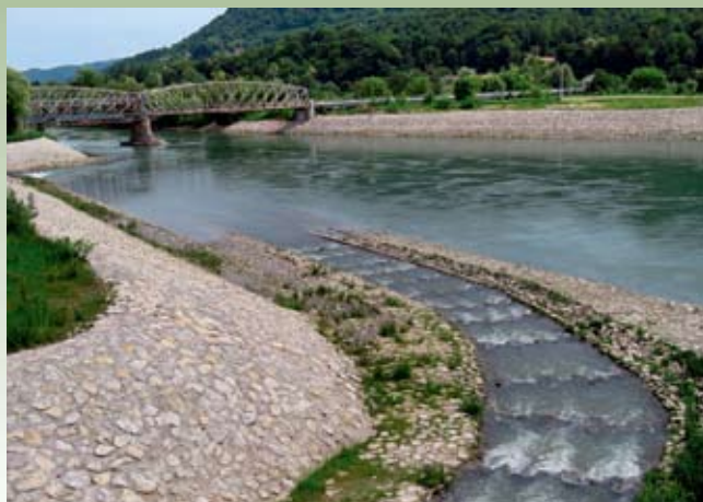
Iztok nadomestnega tekočega habitata in pričetek selitvene poti rib med spodnjo ter zgornjo vodo reke Save.
