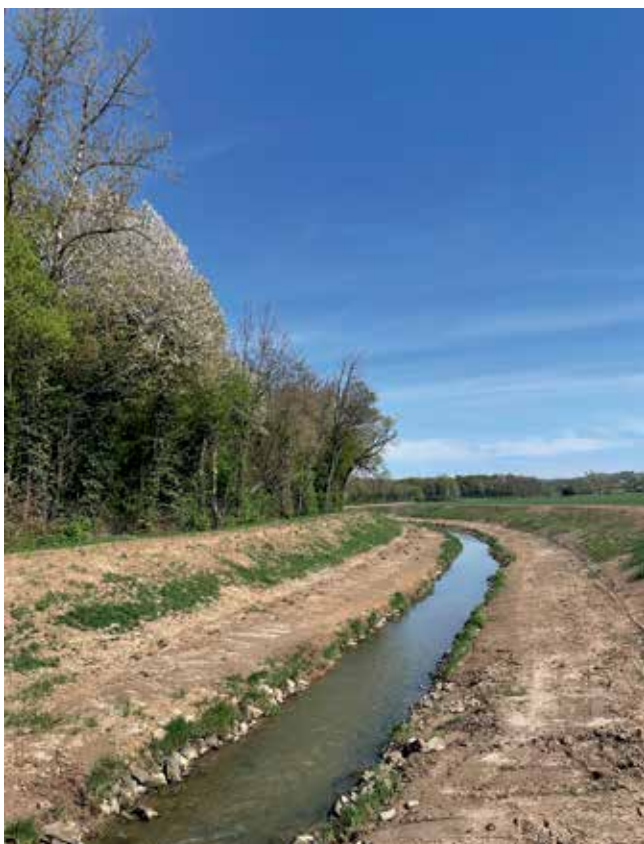
Ščavnica – popolni posek obrežne zarasti
