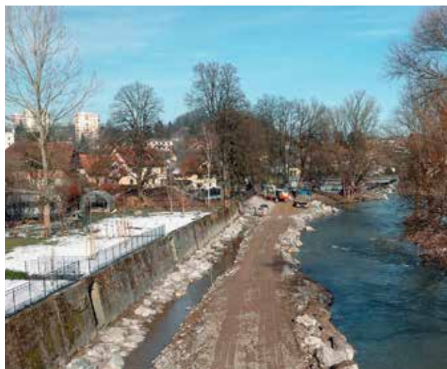
Slika 2: Pogled na del sanirane struge in dovozno pot za gradbeno mehanizacijo (foto: G. Berčič).
