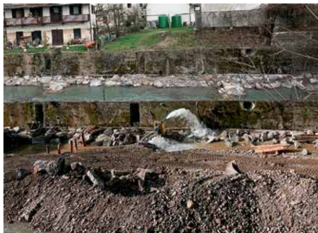
Slika 4: Pogled na sanacijsko delovišče pod mlekarno v Škofji Loki (spodaj) in saniran del brežine (zgoraj) (foto: G. Berčič).
