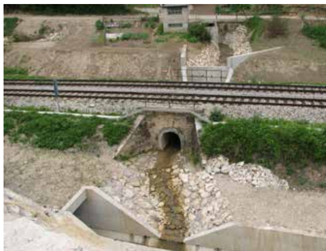
Z lomlencem oblečeno korito in visoka betonska zaplavna pregrada sta prekinila selitveno pot rib.
