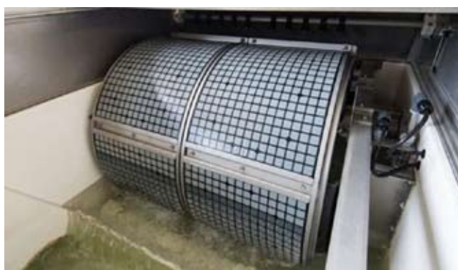
Slika 3: Bobnasti filter (drum filter) učinkovito odstranjuje delce, manjše od 100 µm, ki jim ni mogoče odstraniti s sedimentacijo.
