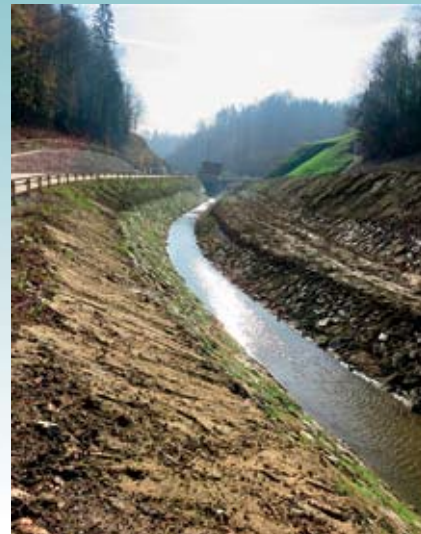
Naravnega korita potoka Maceljčice ni ostalo niti za vzorec, v novem pa prav nobenih pogojev za preživetje rib in rakov, ki so prvotno množično posejevali ta vodotok.
