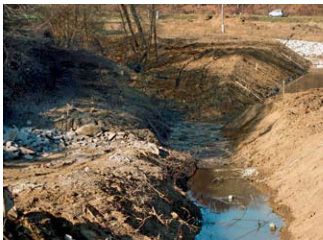
Starega naravnega korita potoka Rogatnice ni več. Ob izkopu novega so ga brez predhodnega odlova rib in drugih vodnih organizmov s premetom zemljin zasuli.
