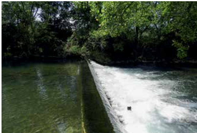
Pregrada pod Zemonom pred izvedenimi gradbenimi deli. Vir: Arhiv ZZRS.
