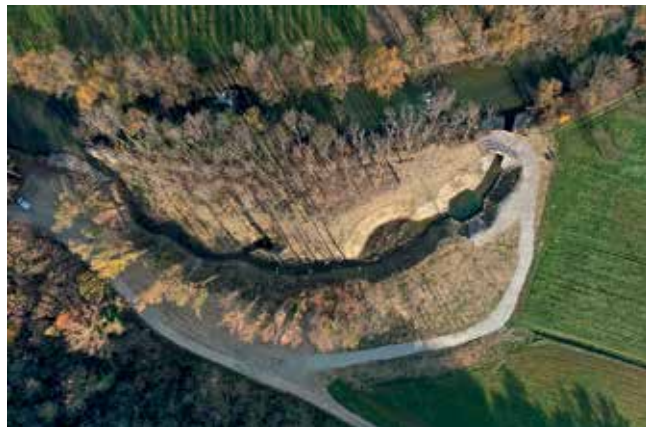
Izkopan stranski rokav Vipave pri Dolenjah nekaj mesecev po končani gradnji. Vtočni objekt s prodnim zadrževalnikom in iztočni del sta utrjena, vmesni del pa je naraven, z razširitvami in zožitvami struge, panji, vkopanimi debli, skalami, pragovi in zatokom. Vir: Arhiv ZZRS.
