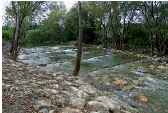
Pregrada pod Zemonom, preoblikovana v serijo petih stabilizacijskih pragov. Med pragovi so izvedene poglobitve – tolmeni. Vir: Arhiv ZRSVN.
