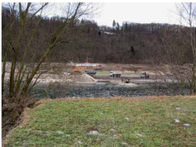
Januarja 2006 so se pričela dela v gradbeni jami načrtovane HE.
