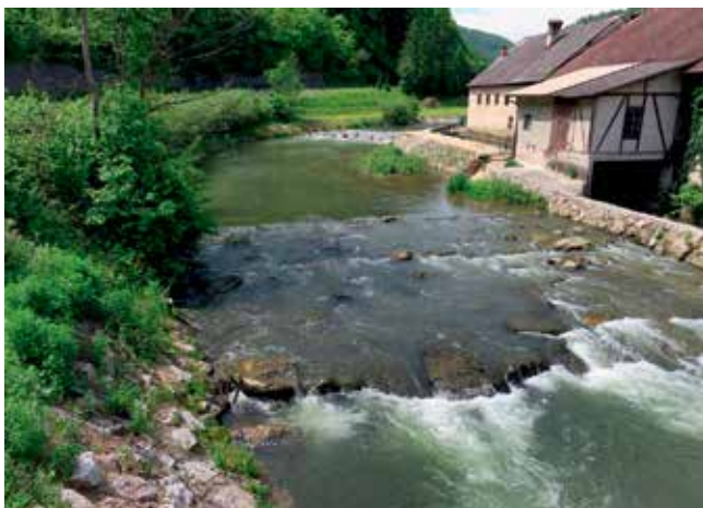
Kaskadno grajen izlivni tok pritoka Mirne je odličen prežračevalnik vode in verjetno tudi učinkovita migracijska pot rib.
