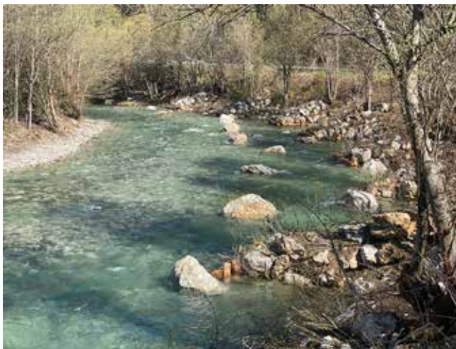
Sonaravna ureditev Savinje nad Ljubnim ob zaselku Trbiž, ki je kljub 90 stopinjskem ovinku in izjemnim silam zdržala tokratno povodenj in ubranila regionalno cesto pred in po povodnji.
