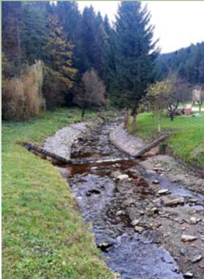
Betonirane brežine potoka Cerkvenica, Vuzenica (foto: Jernej Košir, 2019)
