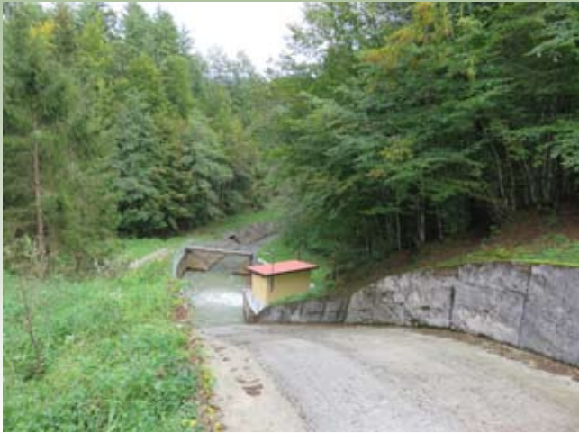
Prelivni objekt z talnim izpustom vode.
