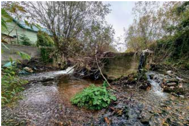
Ostarela ovira na pritoku reke Vezišnice v Črni gori, ki je bila odstranjena leta 2021.
