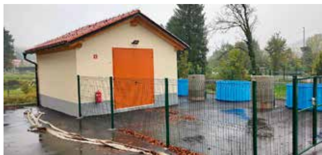
Ribogojnica Soča v Kobaridu ima tudi lasten karantenski objekt. Foto: Blaž Zidarič.
