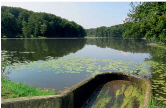
Unikatno oblikovan varnostni preliv visokih voda.
