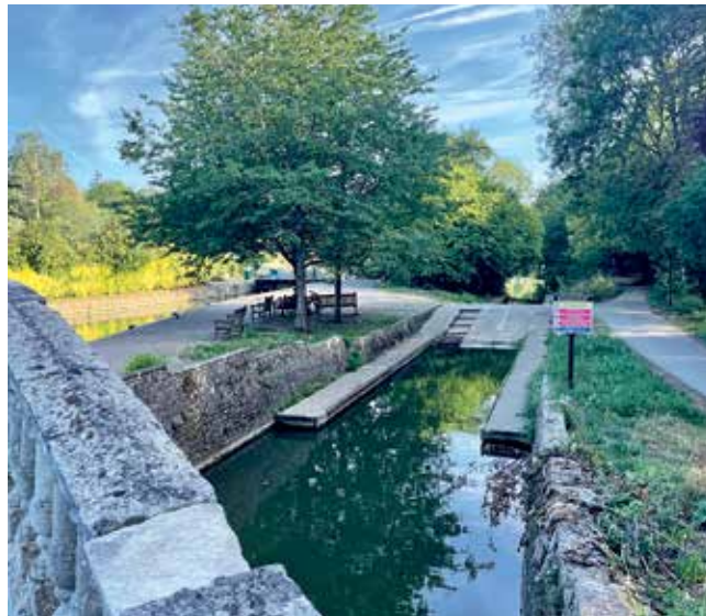
Zapornica Iffley Lock na reki Temzi (Oxford), ki predstavlja objekt, ki je grajeno javno dobro
