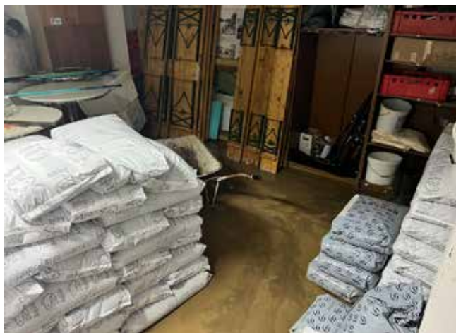
Poplavljeni prostori ribiškega doma
