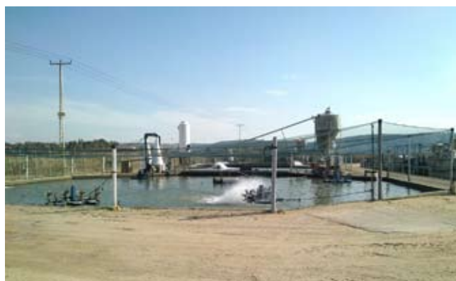
V Izraelu se je uveljavila tehnologija BOB za vzrejo vrst z višjo dodano vrednostjo (Baramundi, Orada); vodo črpajo iz morja, ribnika ali podtalnice in prečiščeno vračajo v morje. Tehnika se je pokazala kot dobra alternativa recirkulacijam in vzreji v kletkah.
