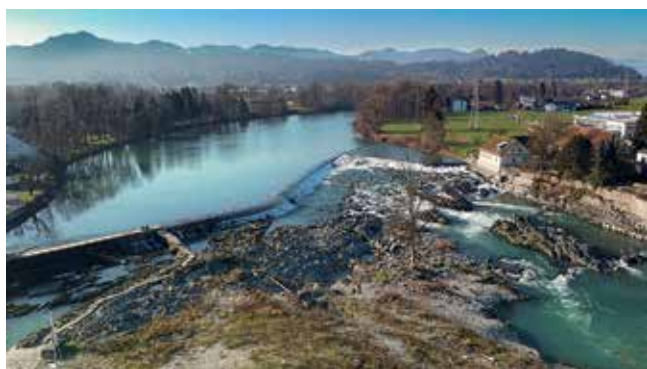
Slika 3 – Tacenski jez v Ljubljani, sestavljen iz skalnatih pregrad v spodnjem delu in gladke, ca. 1,8 m visoke vertikale v zgornjem delu. Prehod za ribe, kamnita drča v prelomni špiči, otežujejo skalnate ovire in razgiban teren spodaj (foto: Gašper Renko). Desno: srednja Sava pri Dolu, ki ji grozi zaježitev (foto: Željko Savič).
