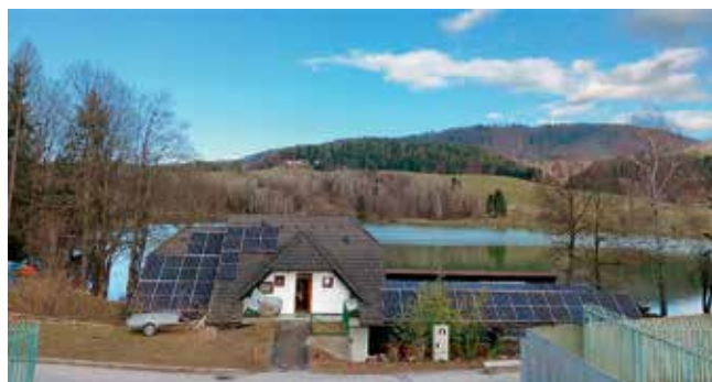
Elektrarna na ribiškem domu
