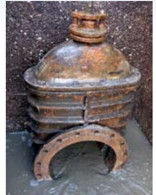
Talni izpust (zasun) brez rešetke za preprečevanje selitve rib.
