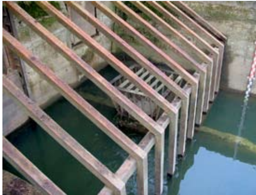
Samo lovilne grablje plavin ne ovirajo prisilne selitve rib skozi talni izpust.
