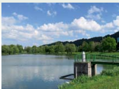
Črpališče tehnološke vode Termoelektrarne Šoštanj
