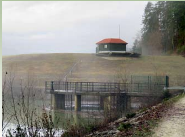
Vlivni jašek in v ozadju nadzorni objekt za daljinsko upravljanje pregrade
