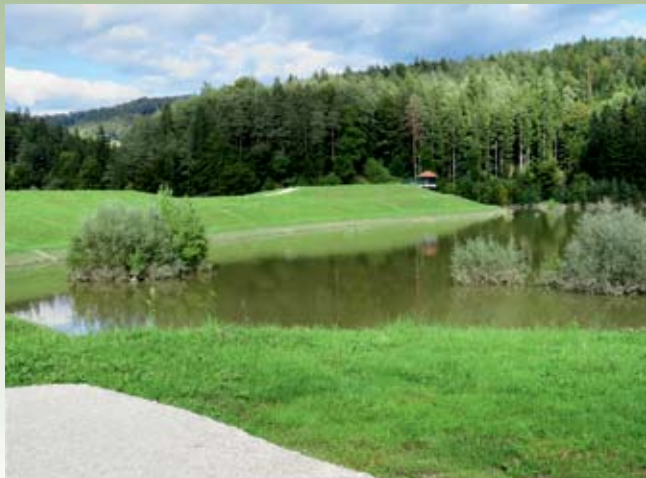
Pregrada z varnostnim prelivom in nadzornim objektom v ozadju
