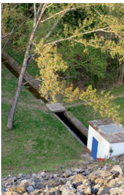
Talni izpust z objektom hidromehanske opreme.
