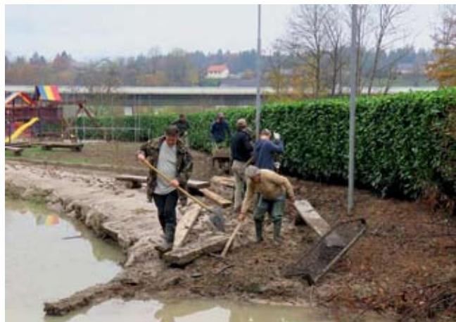
Sanacija dotoka v komercialni ribnik
