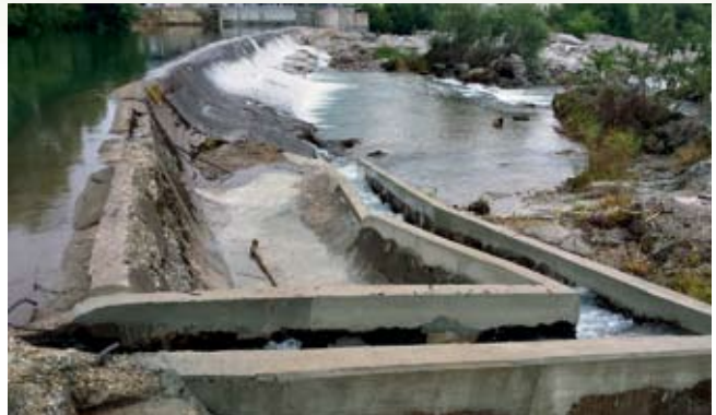
Obnovljene stene korita ribje steze
