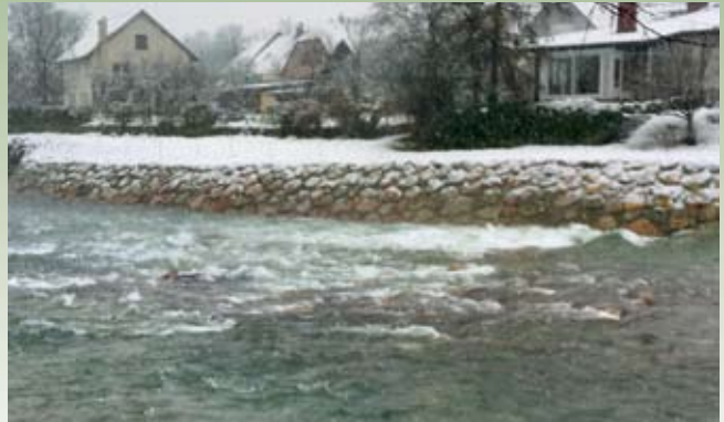
Ista brežina po gradbenem posegu. Dostopa do vode ni več.
