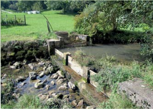
Prelivni prag z bočnim odvzemom vode iz potoka Trnava za napajanje ribogojnice
