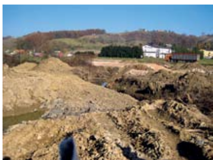
Izkopi novih korit z neposrednim premetom zemeljskih materialov v okljuke prvotne struge. Na predhodni odlov rib, rakov, žab, školjk, ... pa so povsem pozabili.
