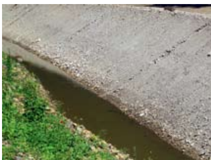
Na polikano brežino bo položena še betonska ali pa kamnita obloga.
