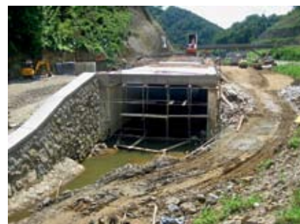
Potok v zaprt kanal, prek njega pa avtocesto. Po končanju del bodo v te podzemne kanale lahko naselili le človeške ribice ...
