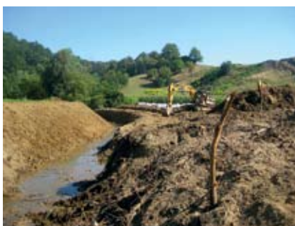
Nova struga je izkopana in stara zasuta, nihče pa ne ve, kje so ostale ribe.
