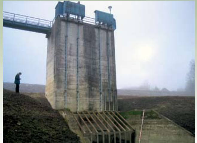
Pregrada z iztočnimi stolpomi in lovilnimi grabljami plavin.
