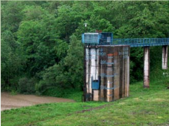
Iztočni objekt z hidromehansko opremo.
