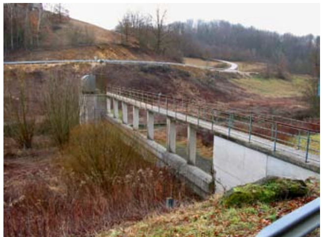
Betonska pregrada Prišlin.
