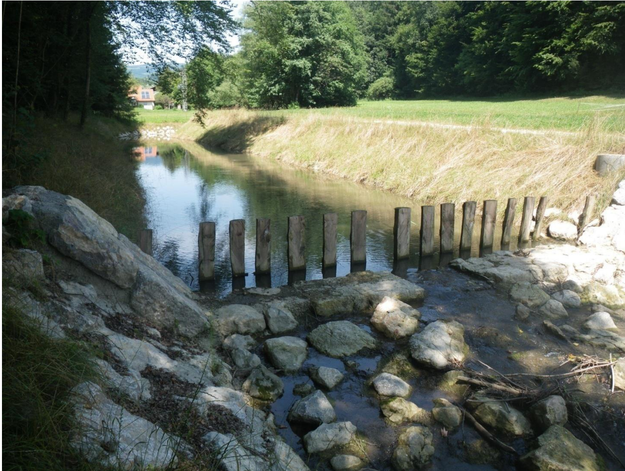
Presladolski potok - gorvodni prodni zadrževalnik kot primer dobre izvedbe (foto: ZZRS, julij 2012)
