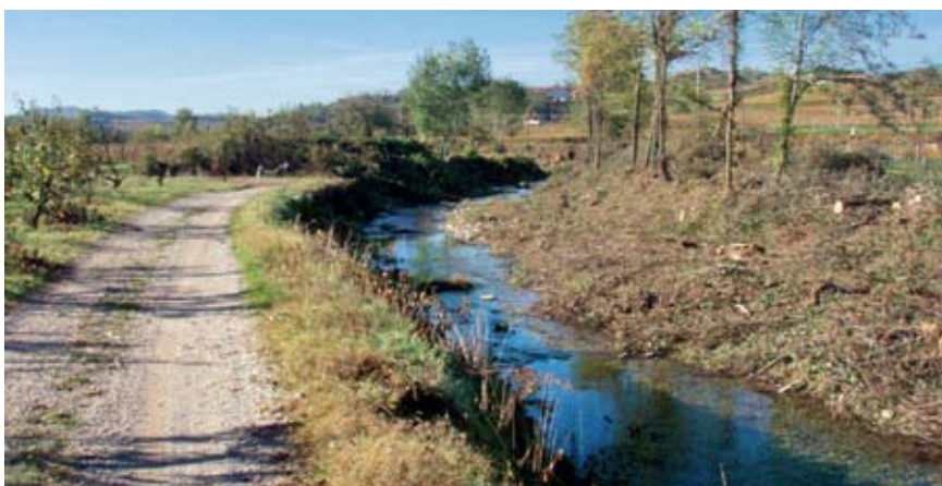
Slika 5: Kožbanjšček 8. novembra 2015 po delno opravljenih delih (foto: M. Radovanović)
