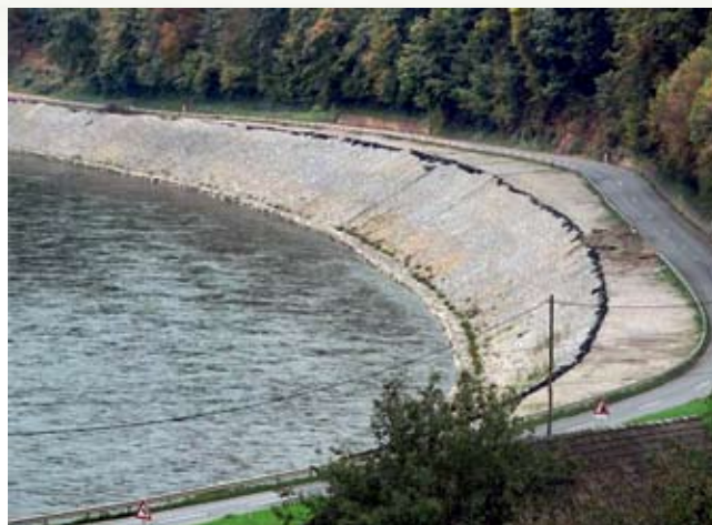
Kilometri zloženega lomljenca in betonskih zidov brez enega samega drevesa.
