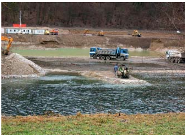
Intenzivna gradbena dela z nasipavanjem gradbenih platojev v pretočnem profilu korita.
