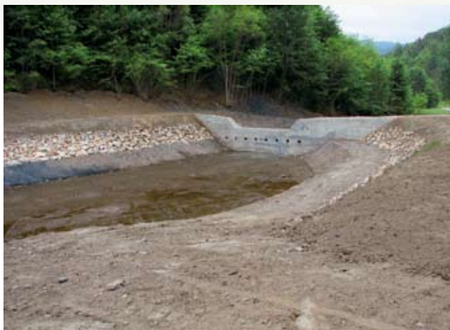
Zadrževalniki plavja z visokimi pregradami so trajno prekinili selitvene poti v pritoke akumulacije.
