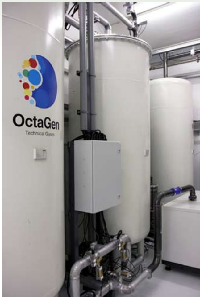
Slika prikazuje VSA generator kisika, slovenskega proizvajalca Octagen (foto: podjetje Octagen)
