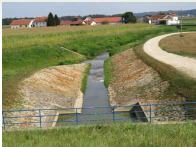
Iztočni kanal za odvajanje jezerske vode v Ščavnico.
